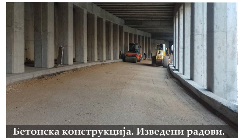
Бетонска конструкција. Изведени радови.
