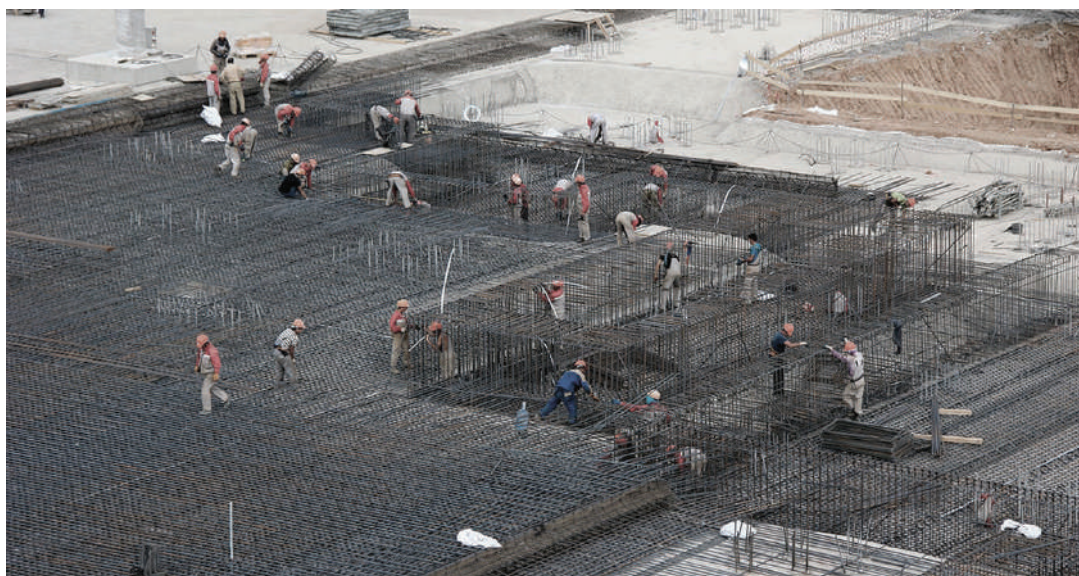
01 Изливање прве темељне плоче 24.06.2014.
