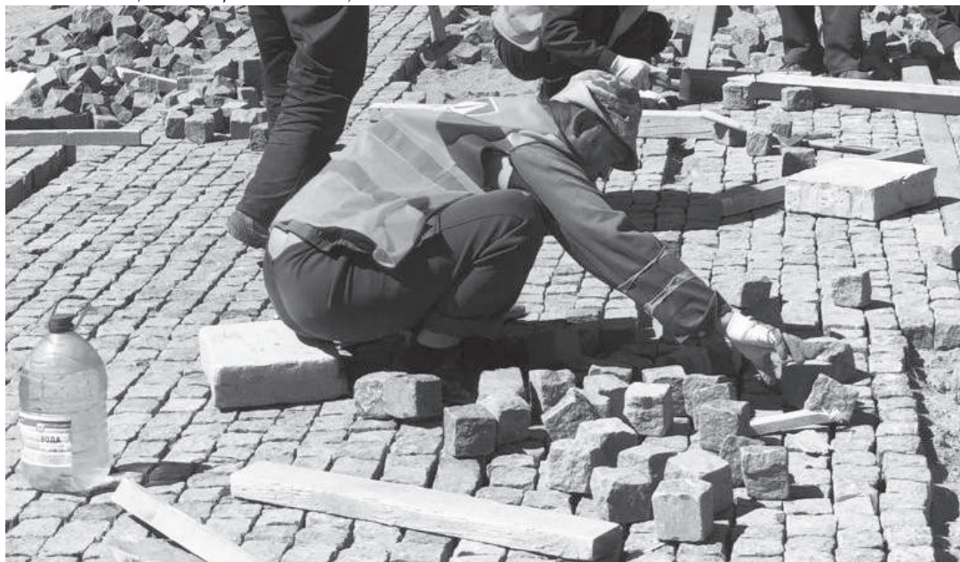
01 Ручно поплочавање гранитне калдрме (45 000 м 2 “цепане” гранитне коцке)
