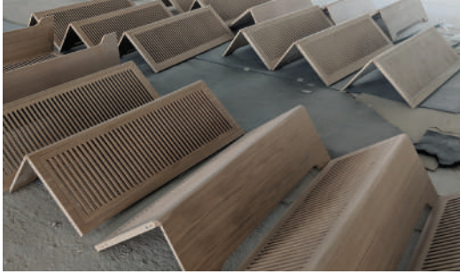
01 Дрвена клупа - пројектована је као вишефункционални специјални елемент вршећи улогу како маске за систем грејања, тако и декоративног елемента на месту интеракције фасадног зида и пода. На објекту је монтирано преко 2970 метара дужних дрвене клупе.
