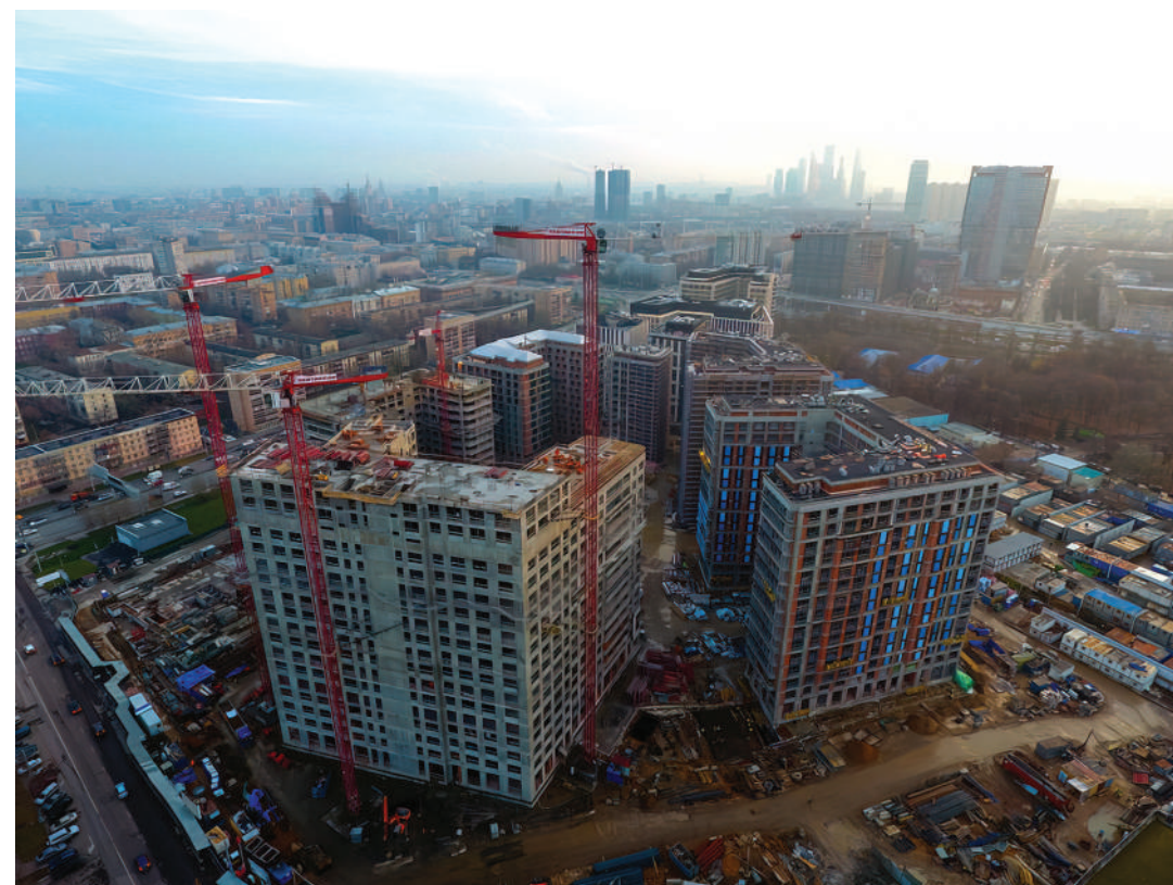
02 Градилиште. Извођење бетонске конструкције
