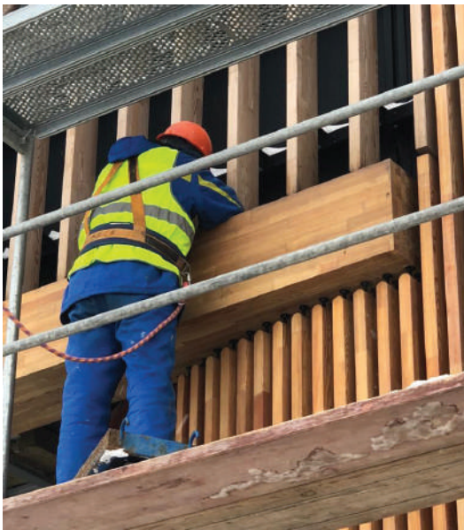
01 Дрвена фасада. Производни процес и процес монтаже ламела
