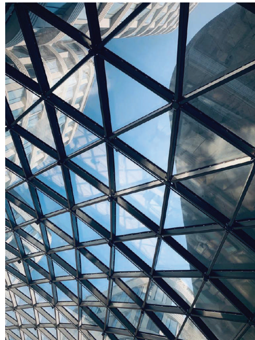
02 Купола атријума. Поглед изнутра
