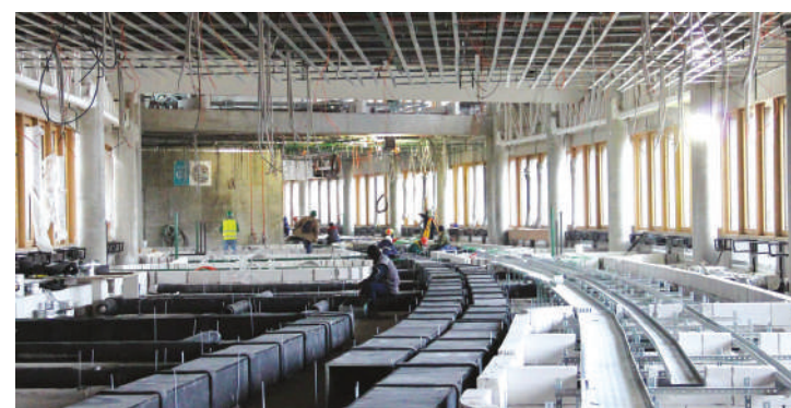
02 Извођење инсталација у зони фалишпода на површини преко 18 000 м 2
