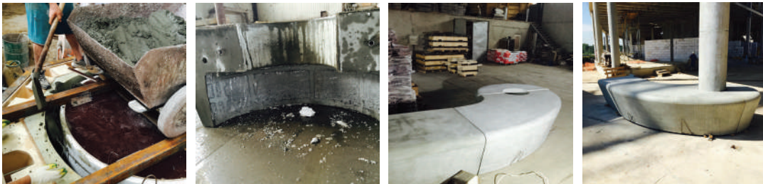
04 Изливање бетона у калупе. Скидање оплате. Монтажа.
