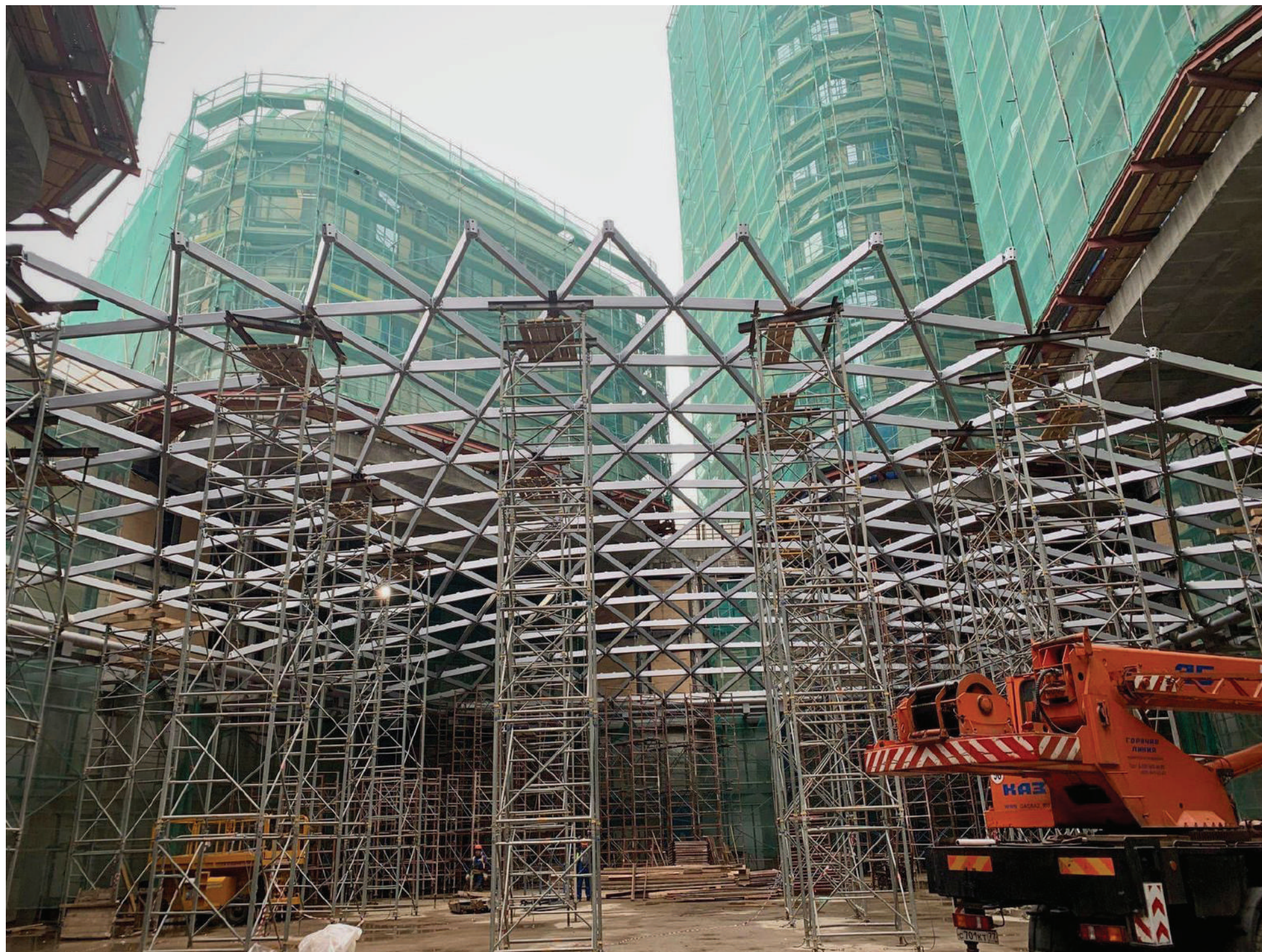
01 Монтажа конструкције куполе на објекту
