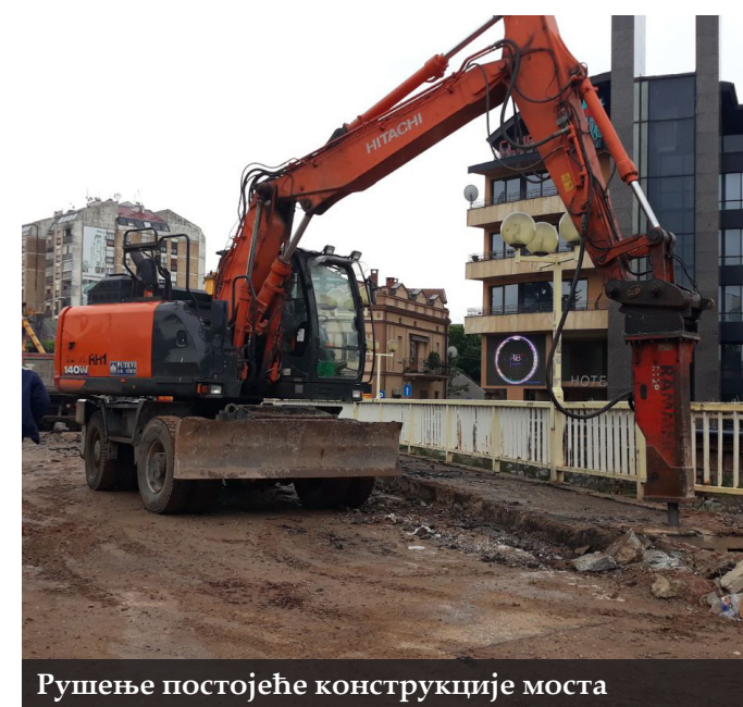
Рушење постојеће конструкције моста
