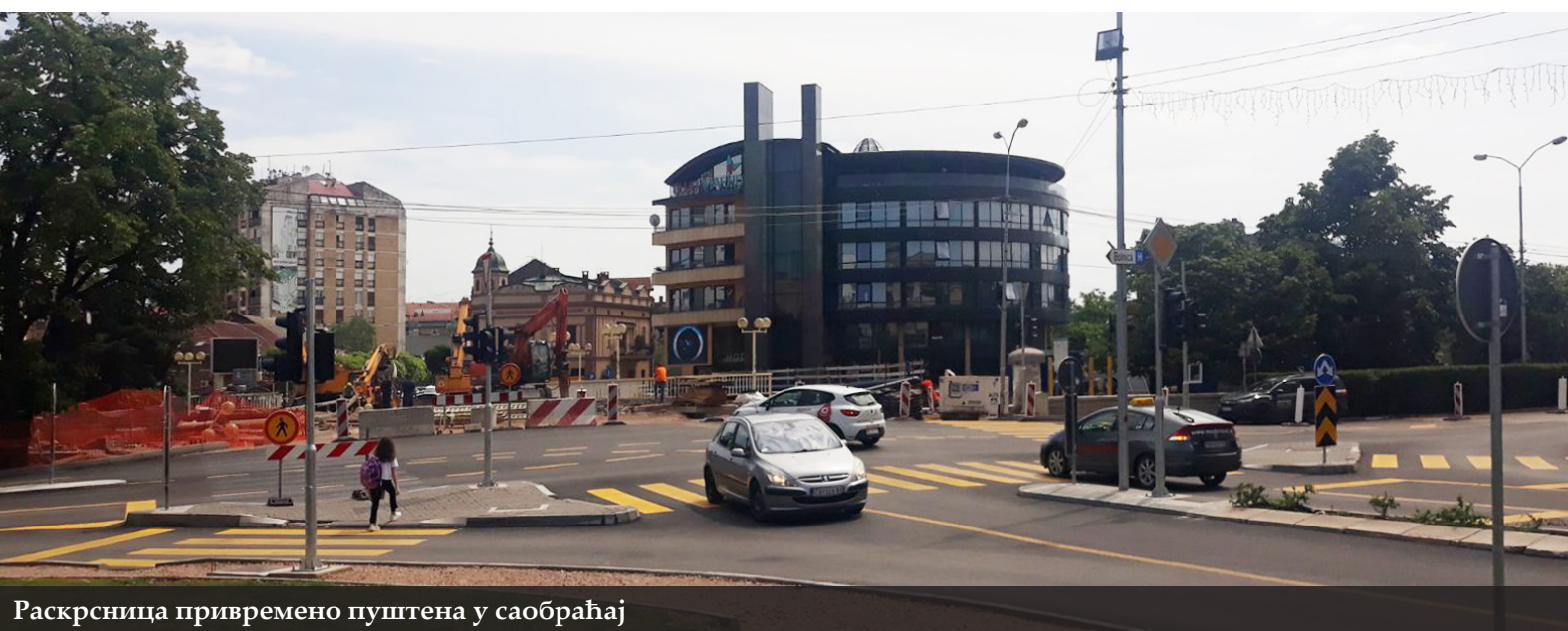
Изведен први слој асфалта и привремена сигнализација
